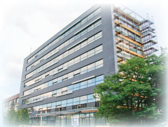
Budynek Biurowy Mera Park w Warszawie – (projekt, dostawa materiałów i montaż) – Inwestor „Mera Pniefal S.A.”
