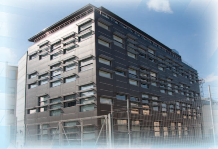
Budynek Instytutu Lotnictwa w Warszawie – (dostawa materiałów) Generalny Wykonawca firma „HARTBEX”
