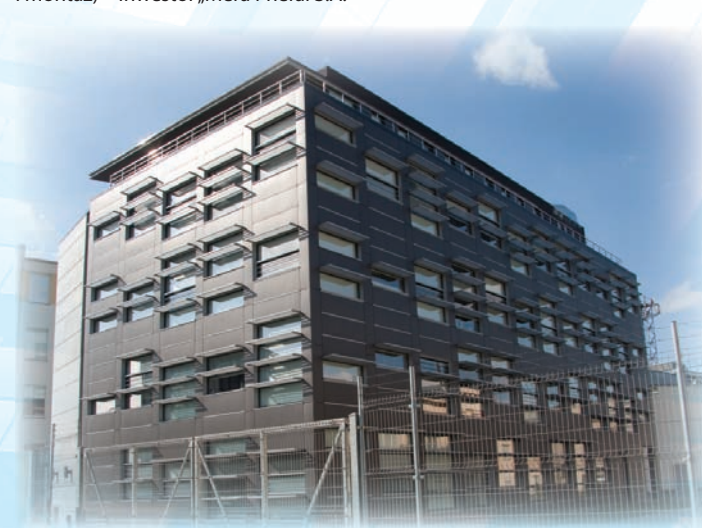
Budynek Instytutu Lotnictwa w Warszawie – (dostawa materiałów) Generalny Wykonawca firma „HARTBEX”
