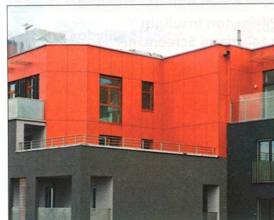
Fot. 1 | Elewacje wentylowane. (Archiwum firmy Euronit)
