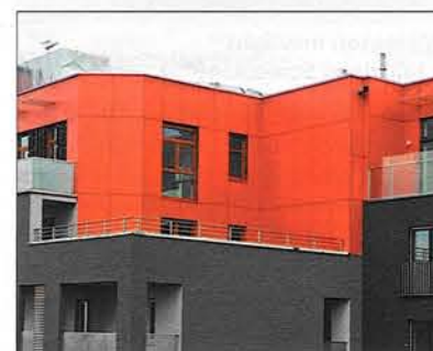
Fot. 1 | Elewacje wentylowane. (Archiwum firmy Euronit)
